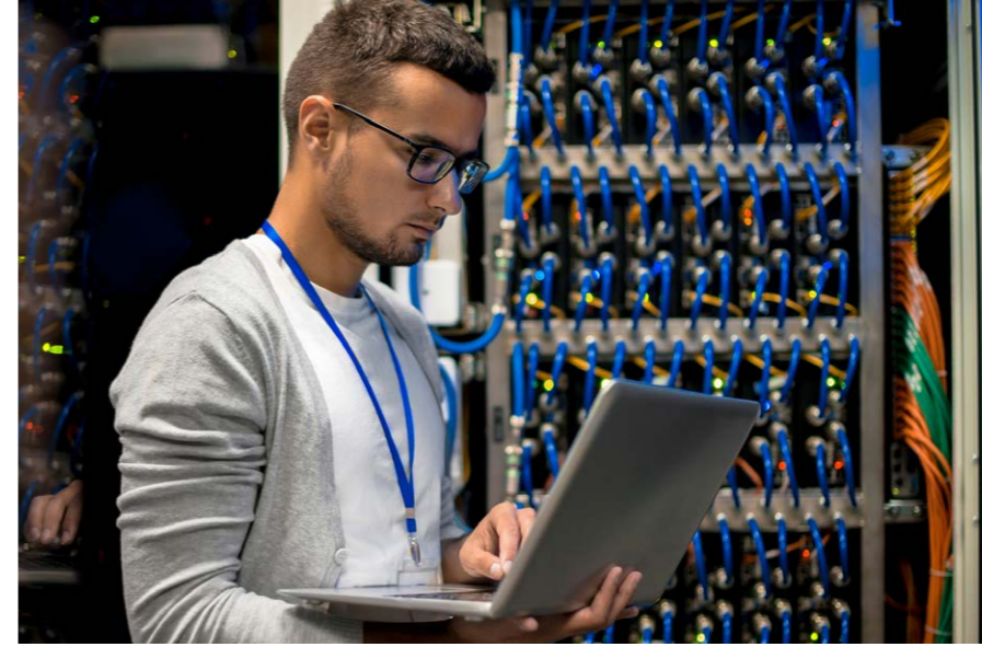
Technicien réseau à l'hôpital
